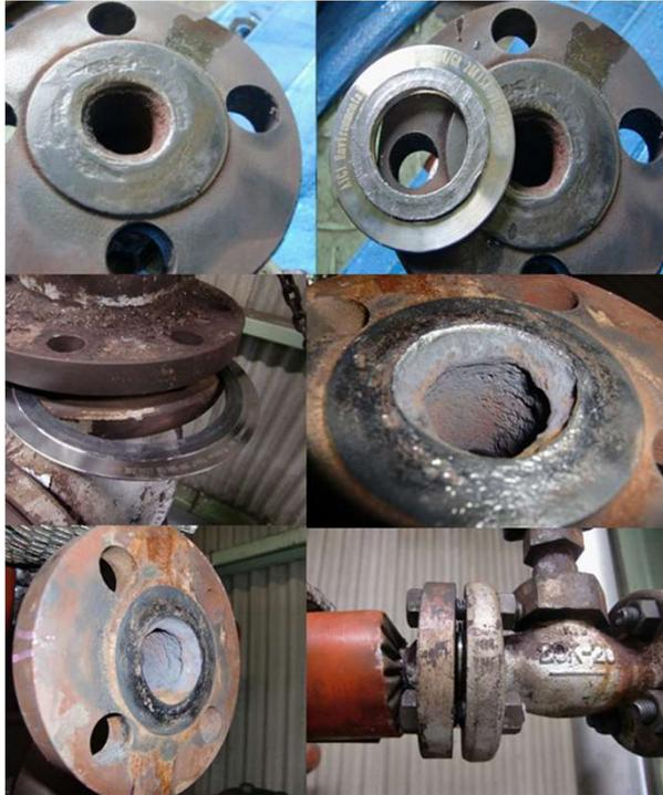
工場が建設から半世紀ほど経ち、貫流ボイラーから送っている蒸気バルブ配管フランジ等の老朽化により荒れや傷があるフランジが多く、工場停止時間等を考慮するとフランジ修正時間が限られているため新品バルブ交換等でグラファイトシートガスケットや渦巻きガスケットに取り換えてもまたすぐ漏れが発生するという状況に担当者は大変お困りでした。
