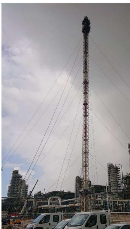
2018年3月南フランスのNaphthachemieという石油化学工場にて高さ50M以上のフレアガスタワートップにFISHBONE®ガスケットを取り付けました。2年弱経った2019年12月現在ホットボルディングや増し締めを全く行わず順調に稼働中です。
